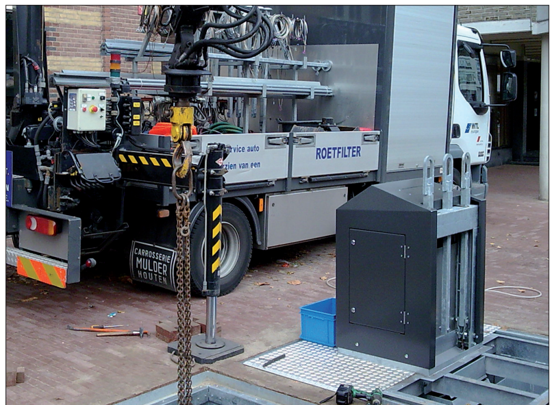
Einbau eines Presscontainers am Koninginnewal in Helmond, NL
