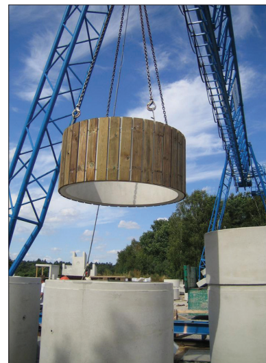
Bereits in der Betonfabrik werden die beiden Teile des Schachts zusammengefügt.
