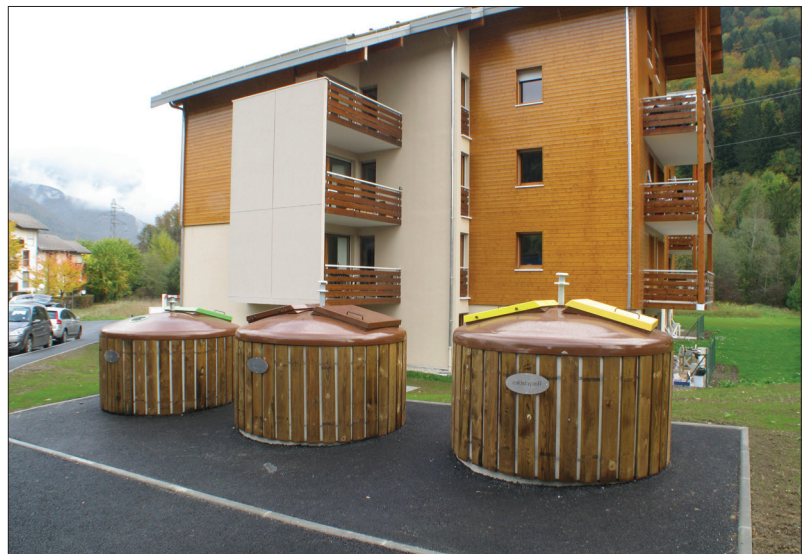
Tièrso-Systeme bei einem Spezialpflegeheim in Thônes (Frankreich).
