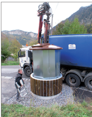
Leerung eines Tièrso Stahl an der Route Nationale (Frankreich).
