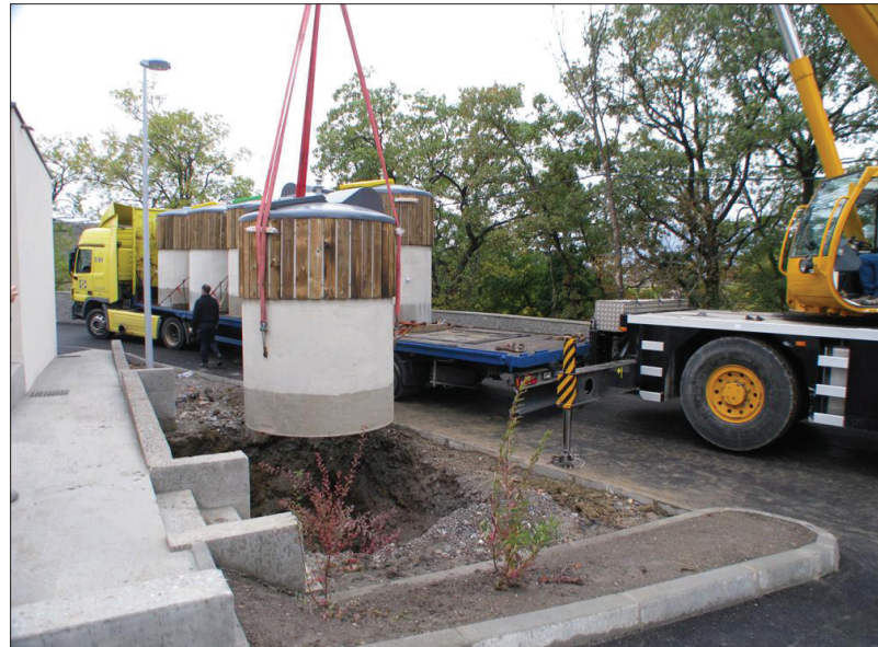
Einbau von TÏerso-Systemen in Gap (Frankreich); nach dem Verfüllen der Baugrube ist das System einsatzbereit.
